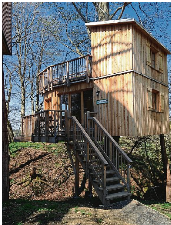
Schwebend: Die Treppe und das Baumhaus sind nicht verschraubt – so kann es frei schwingen
